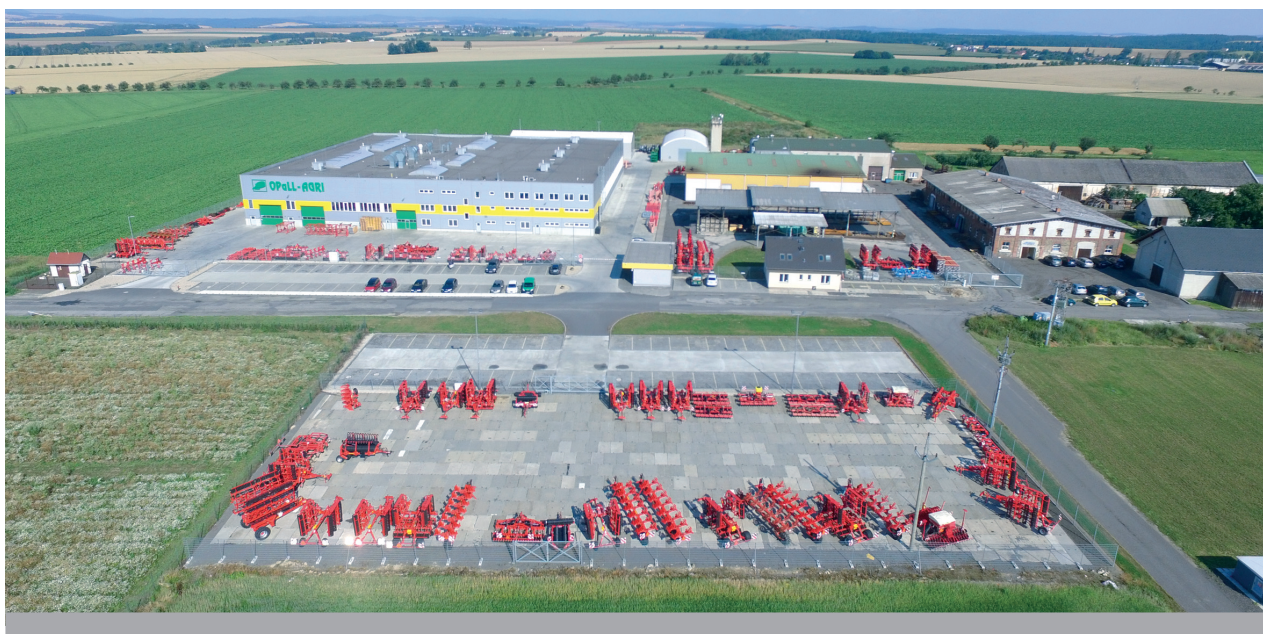
Nová moderní výrobní hala o výměře téměř půl hektaru.
